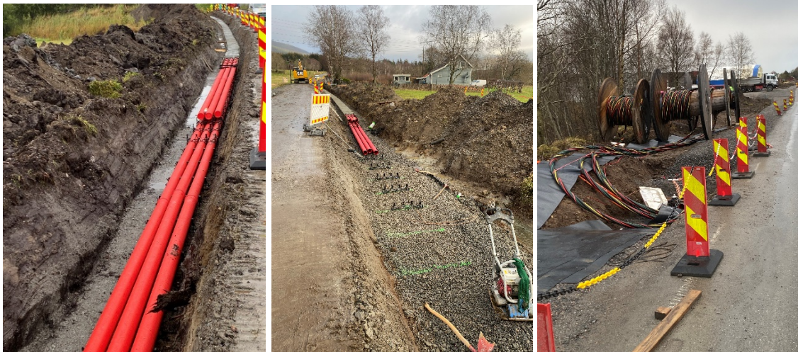
Figur 3. Bilder fra arbeidet med etablering av kabelkanal.
